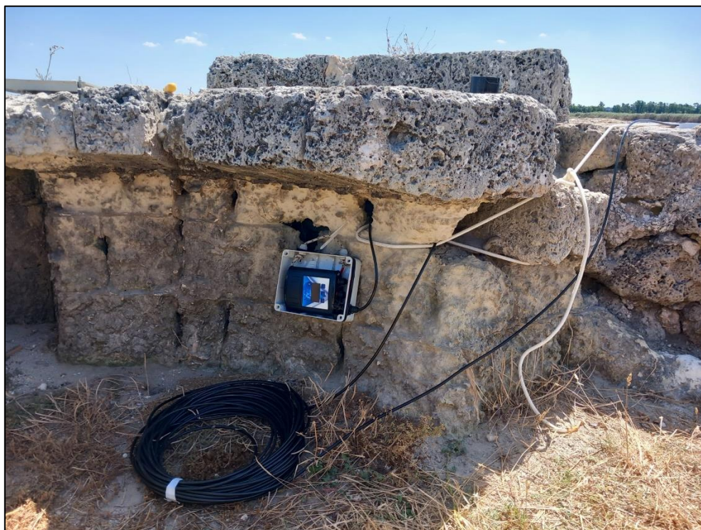
Figura 14 – Installazione mareografo – Unità di superficie
